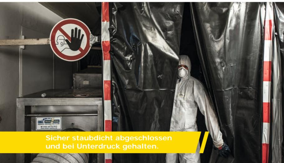
Sicher staubdicht abgeschlossen und bei Unterdruck gehalten.
